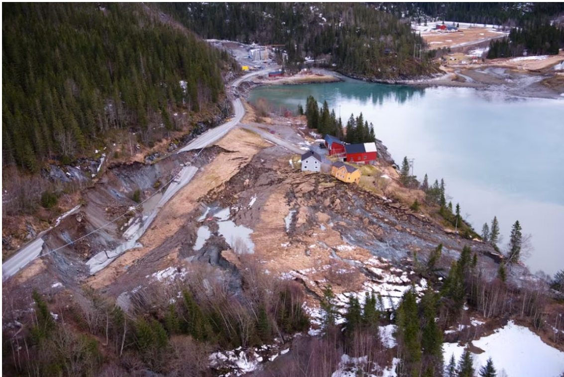
Figur 2: Raset i Tosbotn (Brønnøysund avis 2016)
