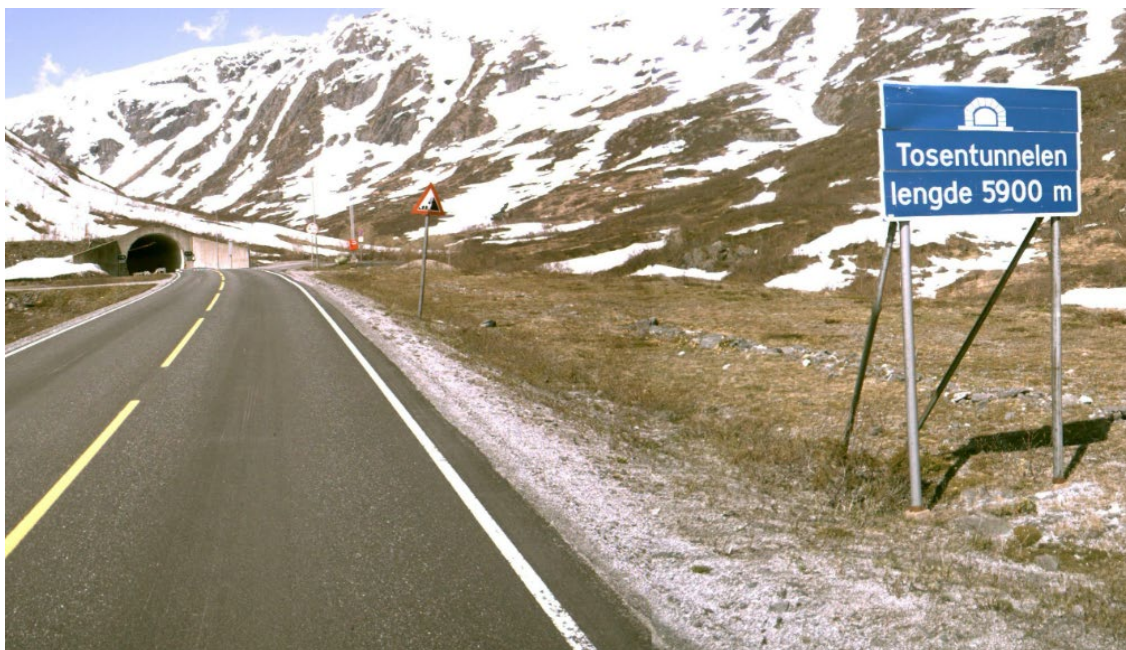
Figur 1: Tosentunnelen i retning Brønnøysund (vegkart.no)
