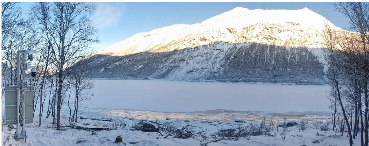
Figur 15 Viser dagens løsning med radarovervåking av fjellsiden som stenger vegen med rødblink hvis et skred oppdages (Foto fra CautusGeo).
