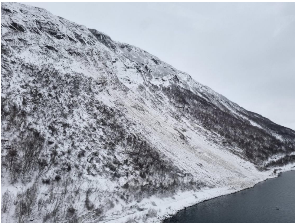
Figur 5 Sist kjente snøskred gikk over vegen 21.01.2022. Merk at skredvinden tok ned mye skog på sidene av skredbanen. (Foto fra Sweco).
