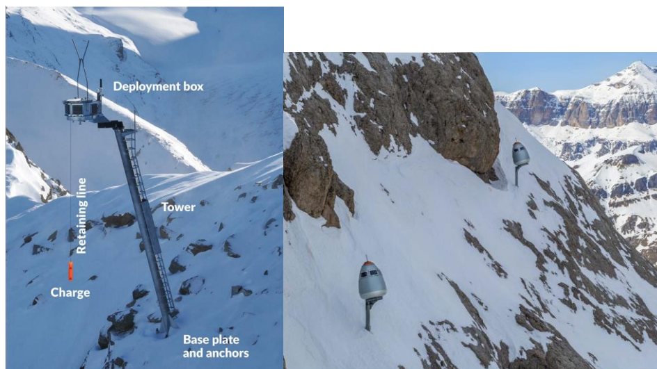
Figur 16 Eksempler på skredtårn med eksplosiver (Wyssen avalanche control) til venstre og skredtårn med gass til høyre (MND).
