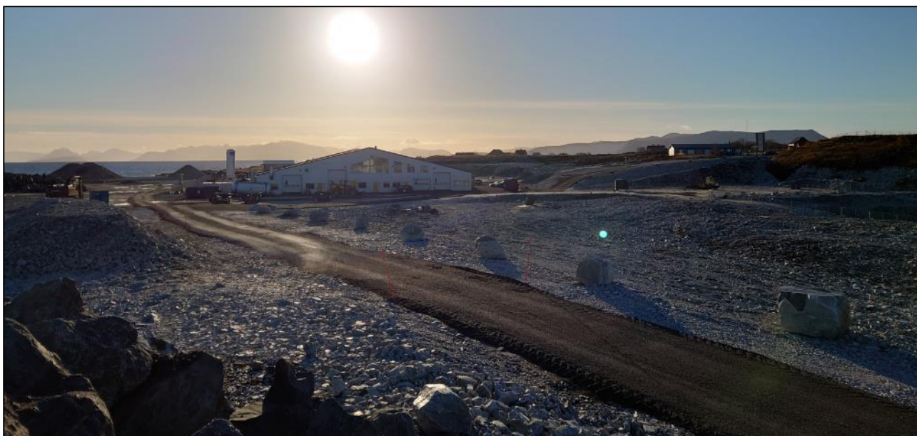
Figur 3-6. Andfjord Salmon – Kvalnes er under utbygging og administrasjonsbygg (Foto: Norconsult, oktober 2022).
