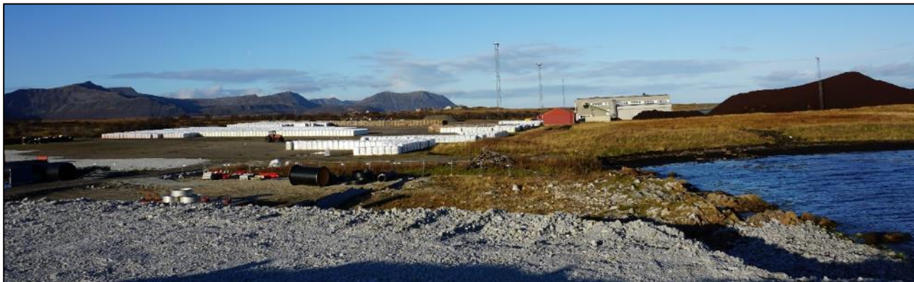
Figur 3-7. Andøy torv - utendørs arbeids- og lagerarealer, samt bygninger (Foto: Norconsult, oktober 2022).
