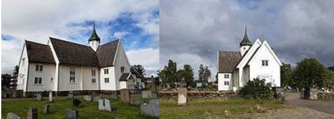
Figur 14: Bilder av Mo kirke. Bilder fra Riksantikvaren.no
