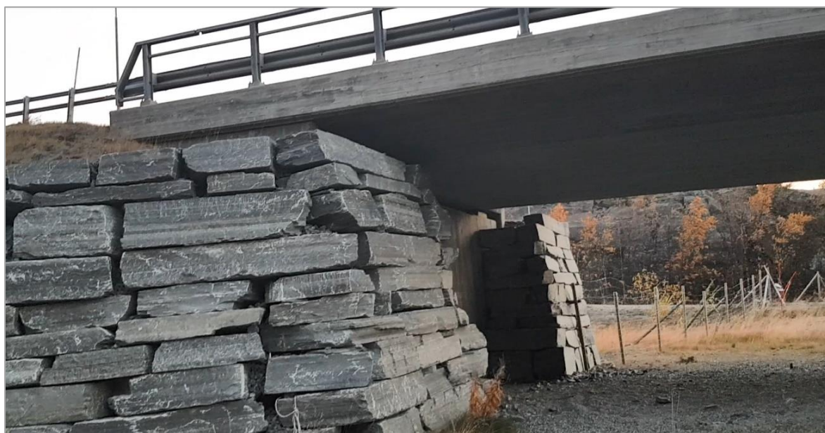
Figur 6-18. Sørlige landkar med mur utenpå. (Foto: Mildrid Elvik Svoen/Sweco Norge AS)
