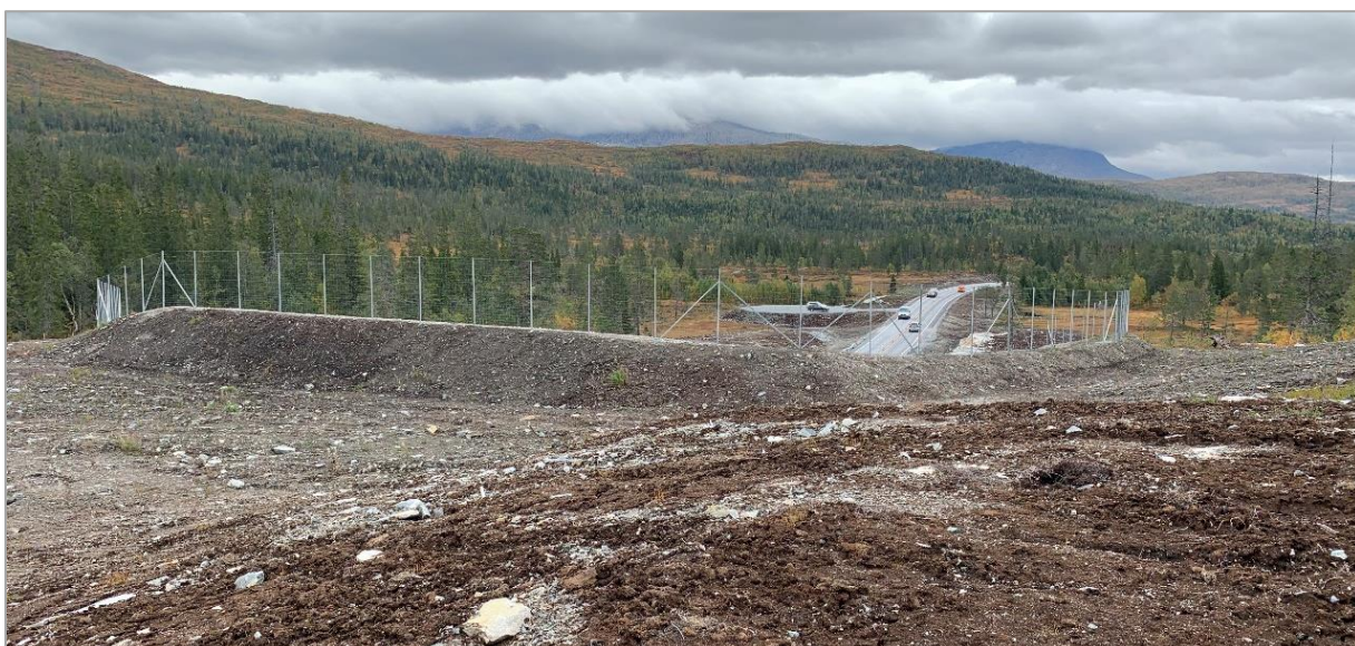
Figur 6-5. Øverst vises passasjen over økoduken sett fra øst. Den tilgjengelige bredden for reinen er ca. 50 m. Nederst vises passasjen sett fra nordvest. Jordvollen er strukket noe sørover for å skjerme mot støv og lysrefleksjoner fra skjæringa, hvor E6 kommer ut under overgangen. På toppen av vollen er det etablert gjerdet. Et stykke sørøst for passasjen er det etablert en parkeringsplass for transport av tømmer. (Foto: Rainer Smedseng/Statens vegvesen)
