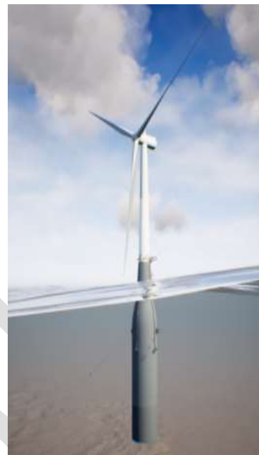
Figur 9 Illustrasjon som viser en ferdig monterte vindturbin på flytende betongfundament. Kilde Aker solutions
