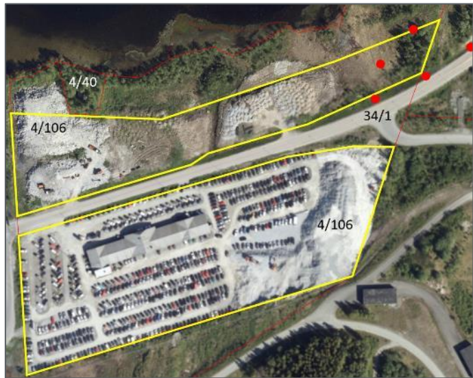
Figur 6-18. Regulert næring- og trafikkareal på eiendom 4/106, sør for Langvatnet, markert med gul linje (Nordlandsatlas). Statens vegvesen har foretatt geotekniske undersøkelser i punkter markert med rødt.
