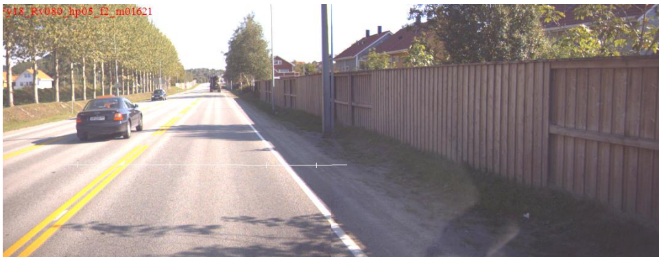
Sted: Rv. 80 ved Bodø. Arealbehov for å ivareta miljøhensyn langs riksveg med støyvoll, støyskjerm, beplantning og gang og sykkelveg på venstre side i tettbygd område.
