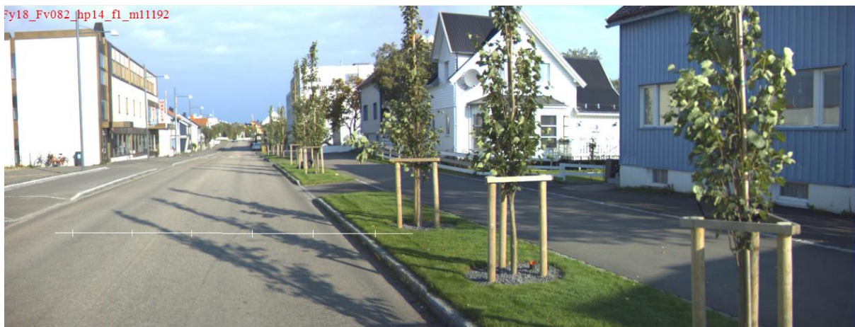
Sted: Fv. 82 Andenes. Bilde etter etablering av Miljøgate.
