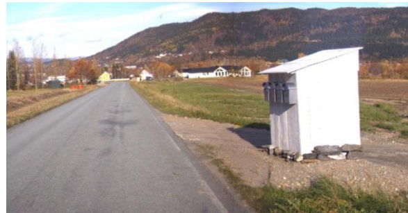
Sted: fv. 7322, Øya i Vefsn. Ulovlig plassering av postkassestativ innenfor byggegrense, og feil utforming av avkjørsel.
