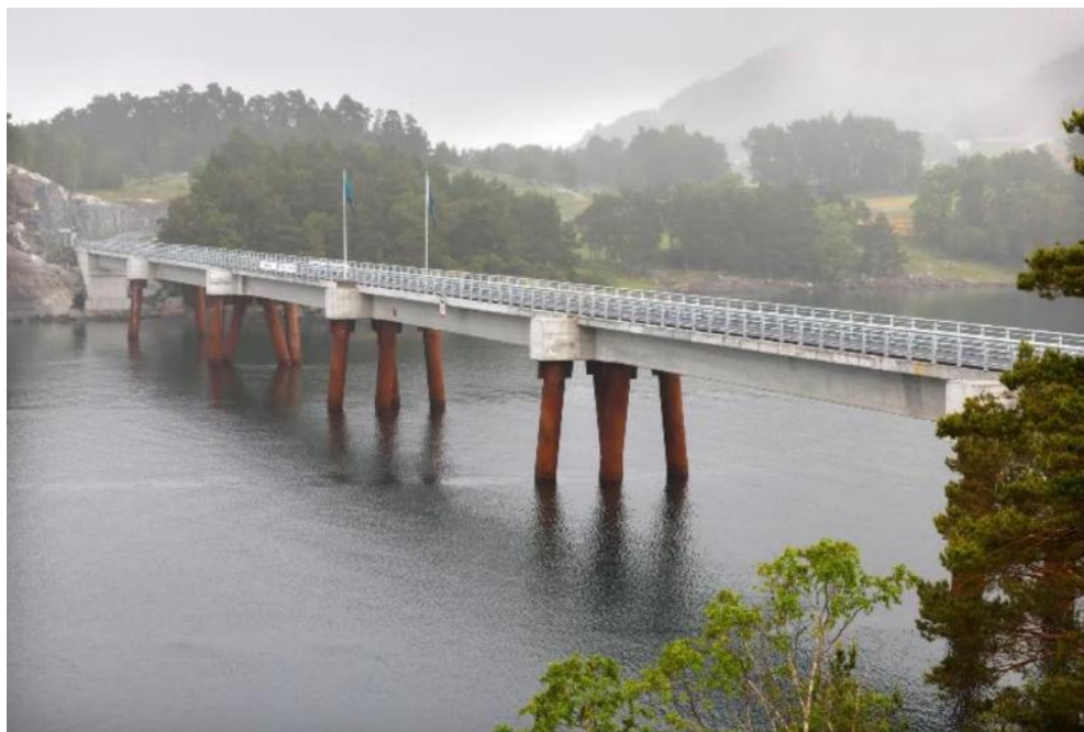
Figur 18 Bilde fra Helgøy bru i Ryfylke i Rogaland som Sweco bruker som et eksempel på en konstruksjon hvor det er brukt prefabriserte kassebruer. Hentet fra Swecos Bru til Hamnøya mulighetsstudie fra 2023.
