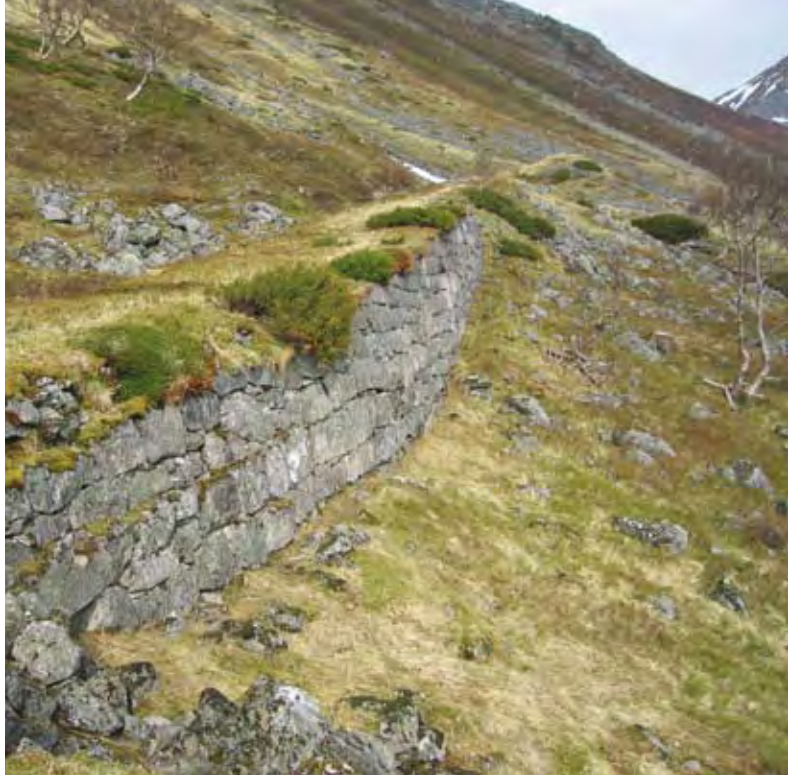
Gruvedrift i Matmora fra 1908 til 1909, Vågan kommune.
