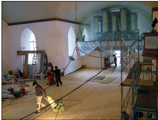
Fra restaureringsarbeidet i Brønnøy kirke, Brønnøy kommune.
