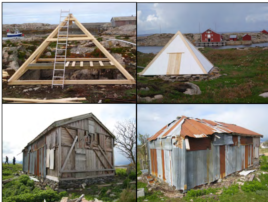
Øverst: Ulike stadier i arbeidet med rekonstruksjon av statsbrønn, Bremsteinvær. Nederst: Ulike stadier av restaureringsarbeidet med Øverstua, Tåvær.
