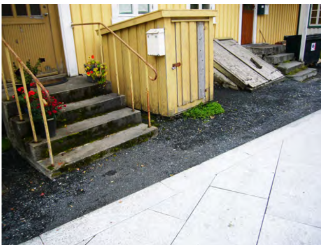
Overgangen mellom nye anlegg og eksisterende, gammel bygningsmiljø: Hva er området tålegrense?
